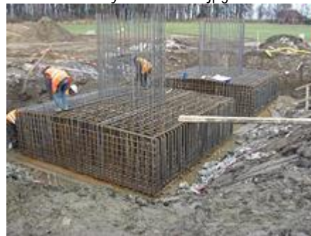
Výztuž základ .jpg
