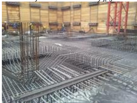
Výztuž základové desky.jpg
