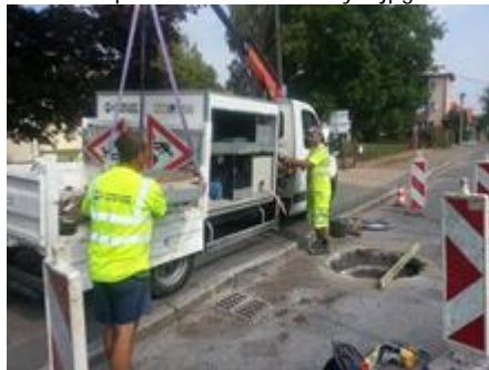
Oprava kanaliza ní...hty 5.jpg
