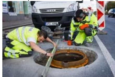
Oprava kanaliza ní...hty 6.jpg
