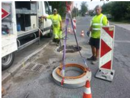
Oprava kanaliza ní...hty 4.jpg
