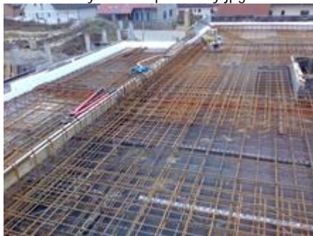
Výztuž stropní desky.jpg
