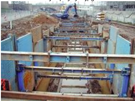
Výkop rýhy 2.jpg
